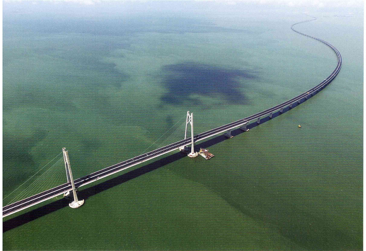
Mit gigantischen Infrastrukturprojekten wie der Konstruktion der Hongkong-Zhuhai-Macao-Brücke im Perflussdelta versucht China, zu Industrienationen wie den USA aufzuschließen.
